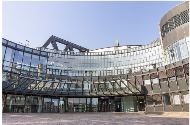
> Neufassung der nordrhein-westfälischen Bauordnung in Kraft getreten
